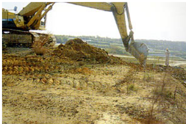
パワーショベルとブルドーザーのコンビは、 地層のはぎとりに力を発揮
