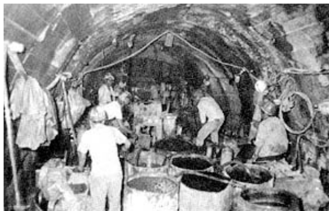
薬液(硬化剤)注入を行ない、岩盤をかためる(芦屋斜坑)。
