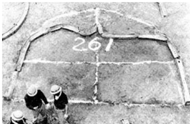
へし曲げられた支保工を組み、圧力の加わった向きを調べる(鶴甲斜坑)。
