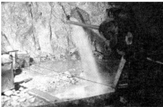
ボーリング孔から水を抜く(本坑)。
