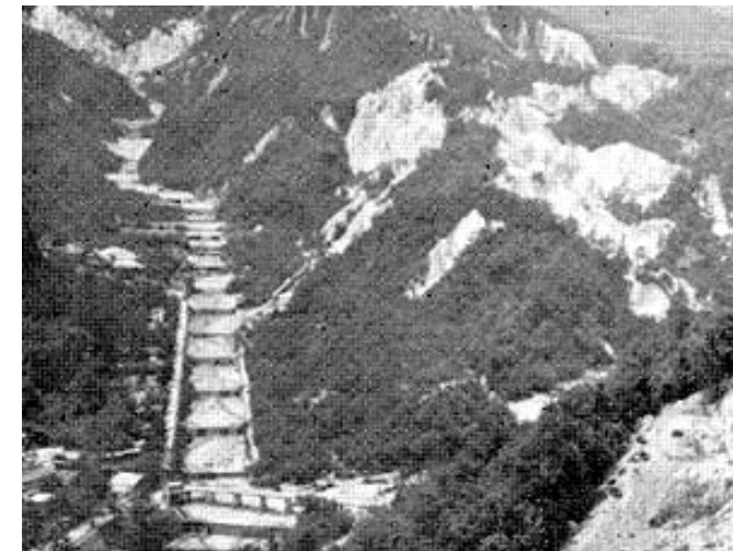
蓬莱峡の砂防ダム
