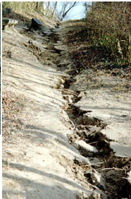
3-7. 道路にできた亀裂（横ずれの力がはたらいたことがわかる）（神戸市兵庫区）
