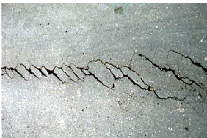
3-7. 道路にできた亀裂（横ずれの力がはたらいたことがわかる）（神戸市兵庫区）
