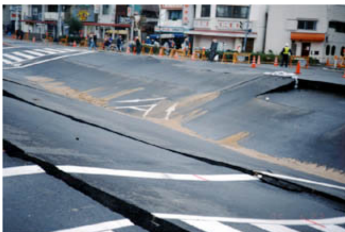
3-3. 地下鉄が走っている上の道路が陥没した（神戸市兵庫区）
