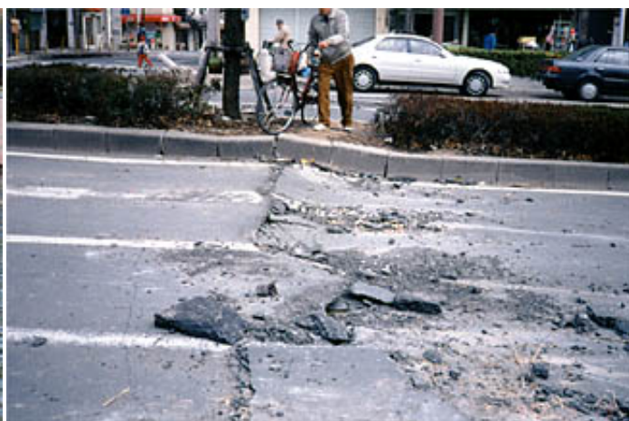
3-6. 道路にできた亀裂（圧縮の力がはたらいたことがわかる）（神戸市中央区）
