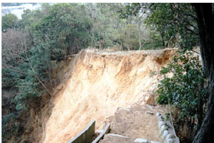
4-1. 六甲山地の各所でがけ崩れが起こった（神戸市須磨区）
