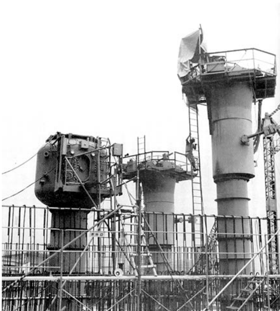
ポートピア大橋の基礎工事の潜函上部・左は作業員が出入りするマンロックで、中と右のシリンダから海底下の軟弱層が運びだされる。（昭和54年6月）
