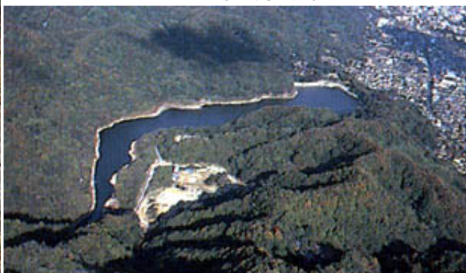
空から見た烏原水源地
