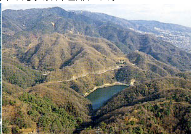
布引水源池。手前中央の影になっている谷を布引断層が通り、池の対岸の影の部分につながる。ここでは断層破碎帯がみえる。
