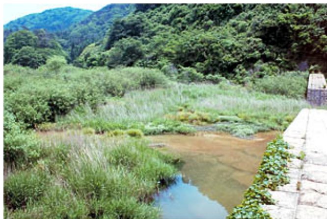
写真 1-2. 住吉川五助ダム(砂防ダム)。
