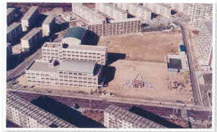
昭和48年10月 全校舎完成
